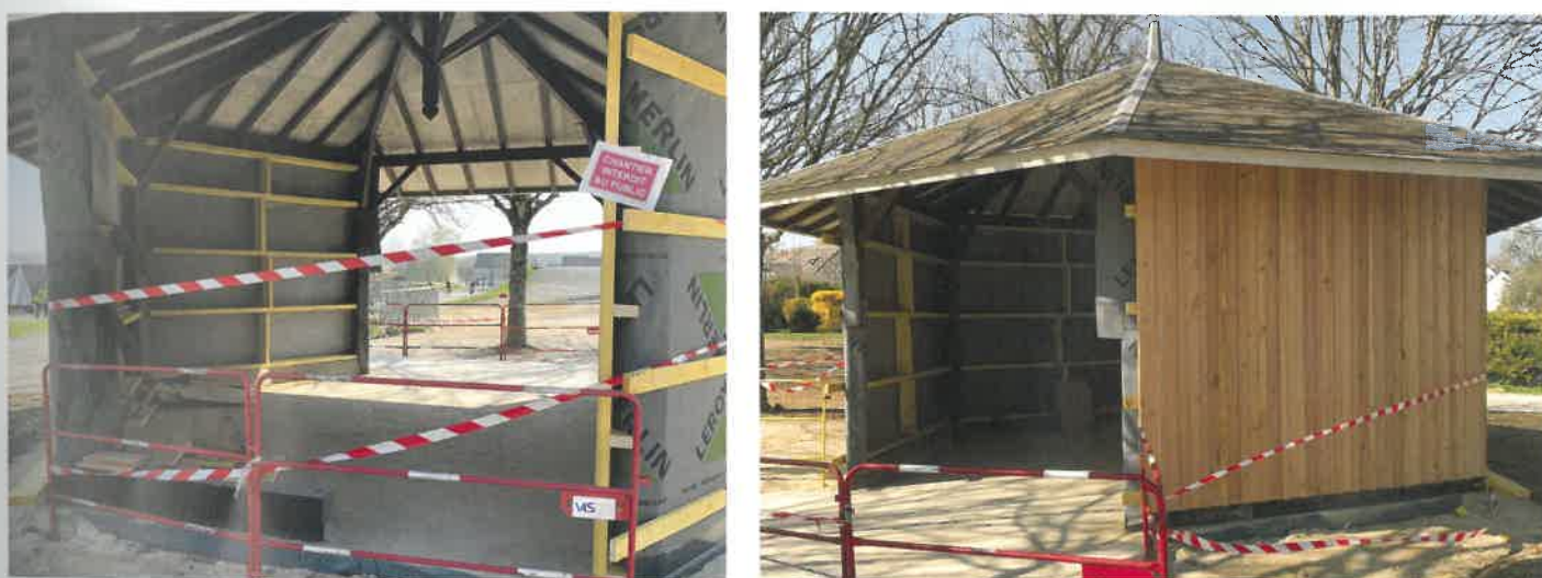
Le kiosque historique (qui servait d'abri et était ouvert aux quatre vents) est en train d'être fermé, mis hors d'eau et sécurisé afin de pouvoir stocker du matériel et de créer un endroit convivial pour la section BMX.
